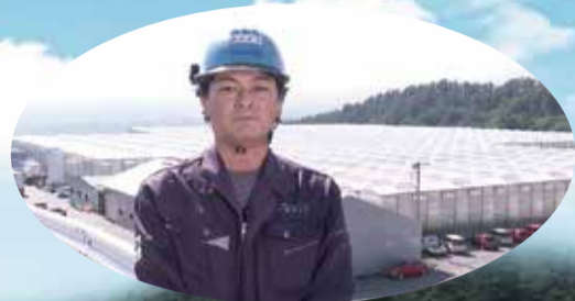
山梨県北杜市の植物工場メンテナンス工事をトダテック工事が担当。2022年6月撮影
