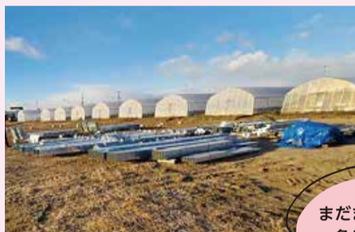
●宮城県岩沼市 鉄骨ハウス倉庫工事
